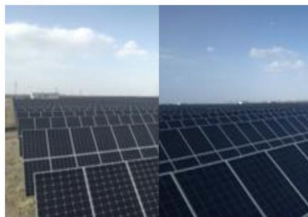
阳光能源青海格尔木10MW单晶系统与10MW多晶系统比较，单晶发电量比多晶高 **5.12%**
