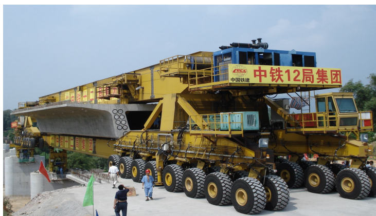
图 17 从路基面上行走到架桥位置
