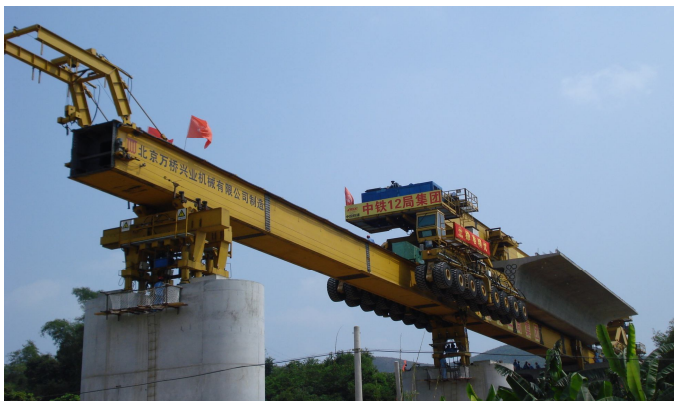
图 5：900 吨穿隧道运架一体式架桥机
