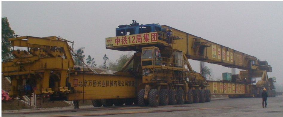
图 7 运架一体机自行转移工地
