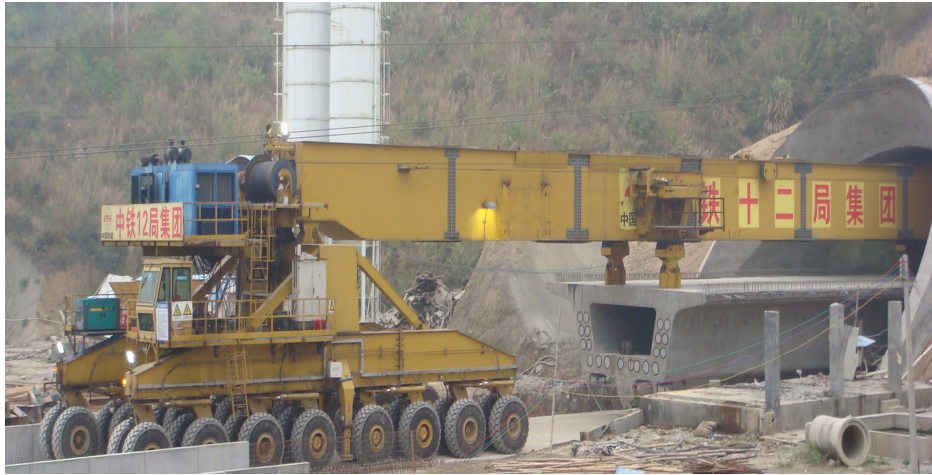
图 6 运架梁机通过隧道运梁
