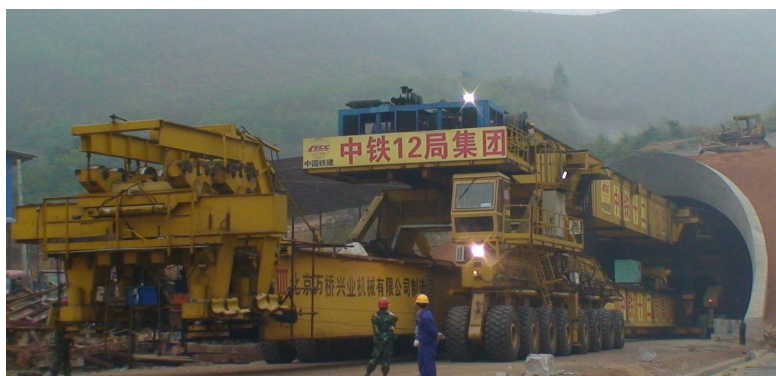
图 11 不拆解部件携带导梁机通过隧道
